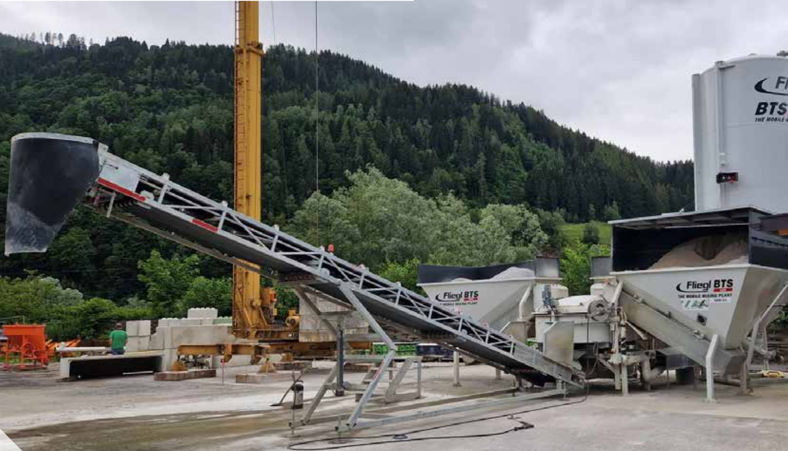
BTS 1000 3 x enkelt aggregat-siloer, overdækket silo, elskab i container
