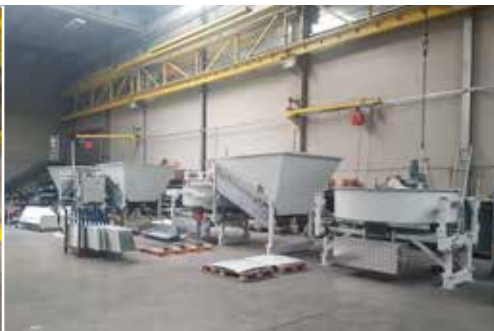
Slutmontering af betonblandeanlæg
